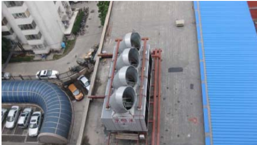
图 4.5-1 冷却塔导向消声器实施实例
