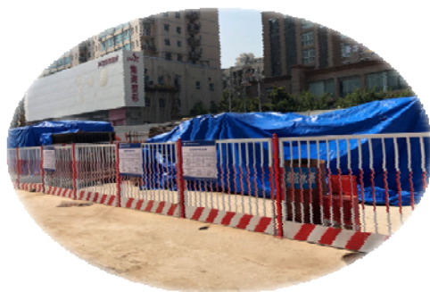
物料堆放覆盖“100%”
