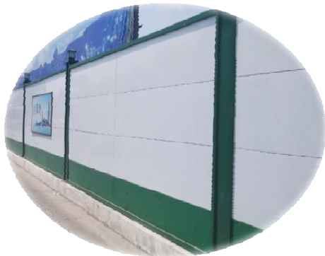
施工工地围挡“100%”
