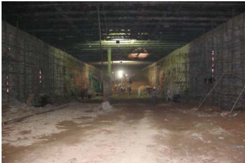
图 2.1-16 盖挖法施工现场
