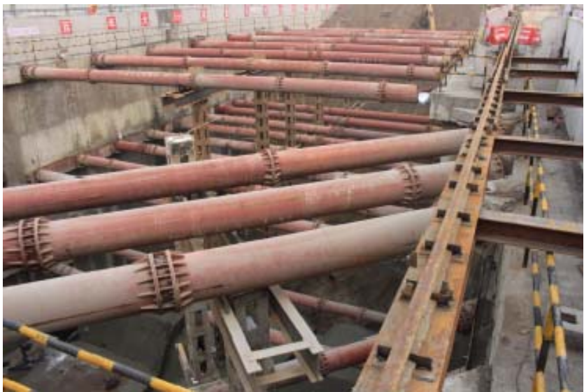
图 2.1-14 明挖法施工现场
