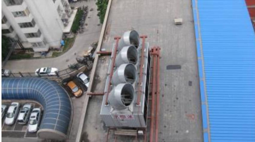
图 4.5-1 冷却塔导向消声器实施实例
