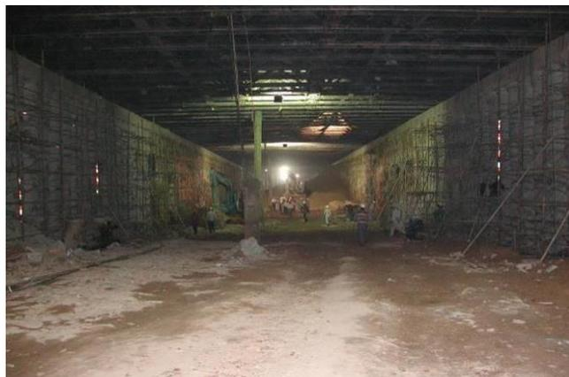
图 2.1-13 盖挖法施工现场
