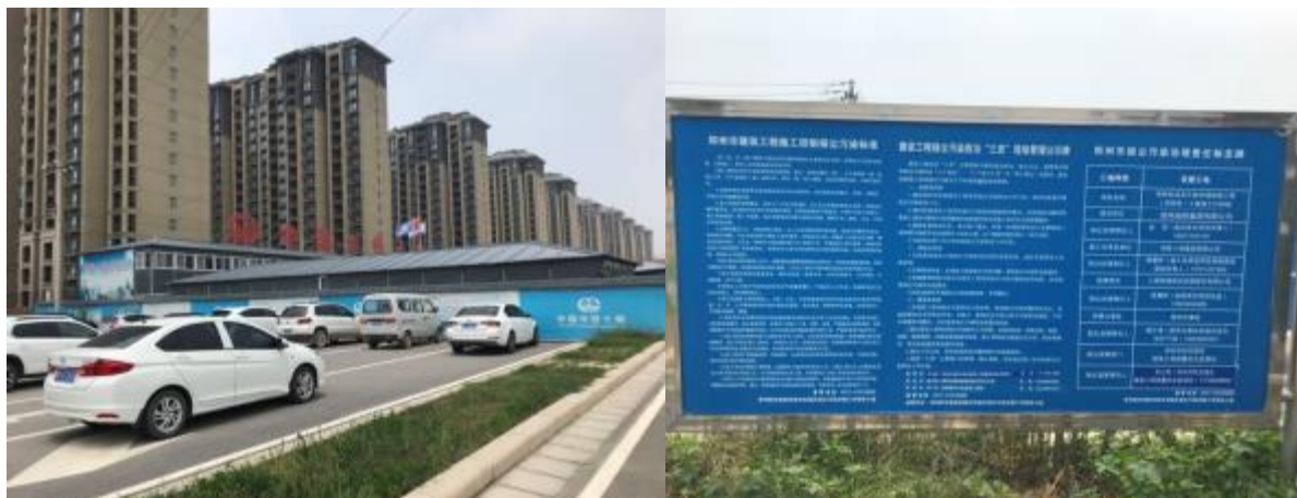
苑陵路站施工场地
