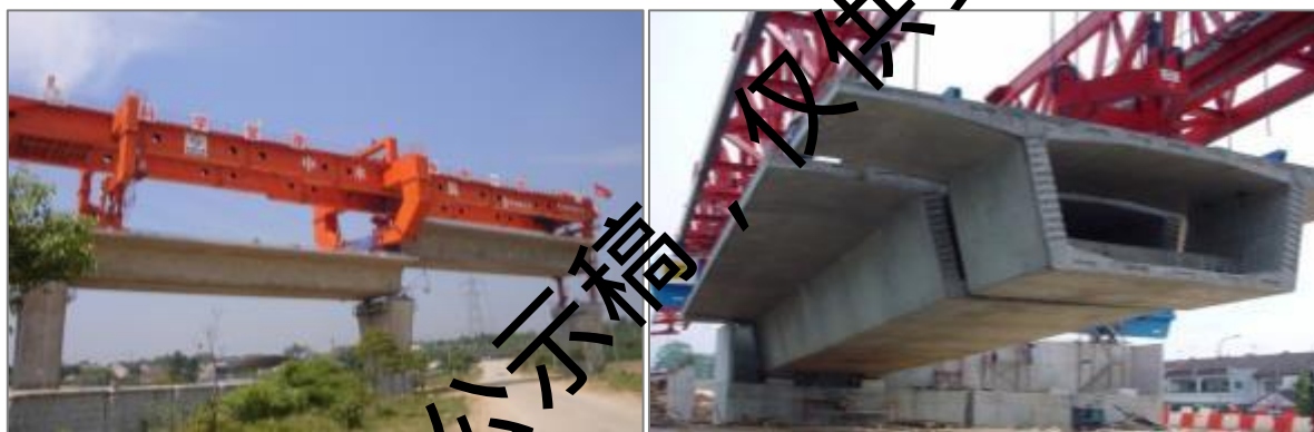
整孔预制吊装施工
