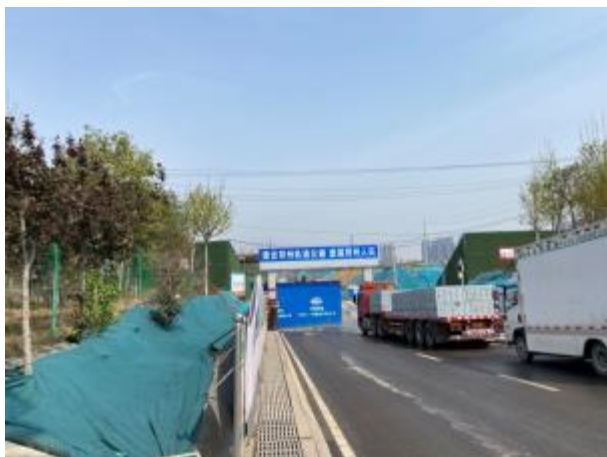
港区北车辆段中铁十一局项目部
